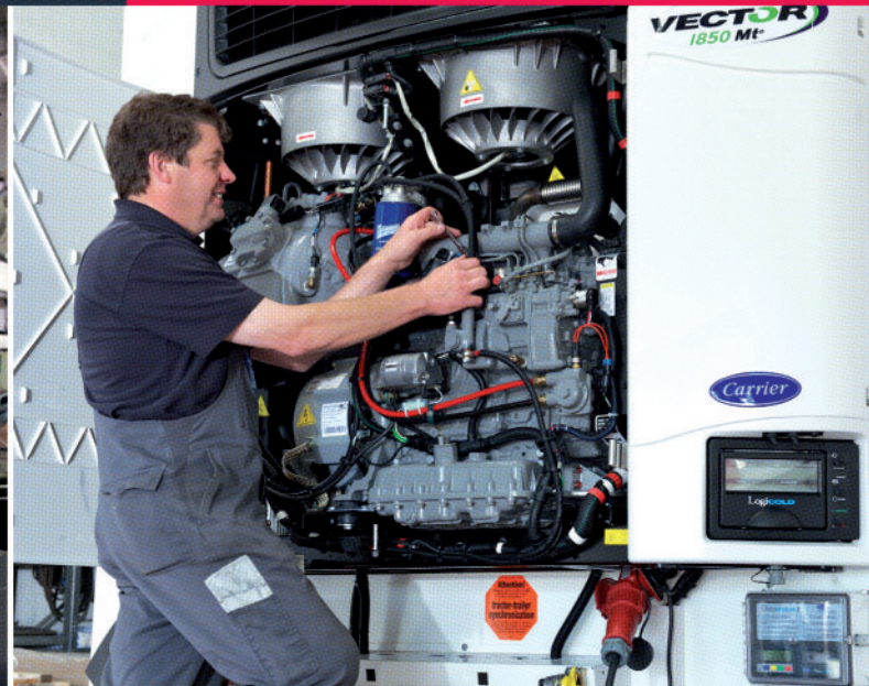
Kühltransporte haben bei uns immer Vorfahrt – damit es schnell geht!
